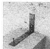
Spoj s međuspratnom konstrukcijom
